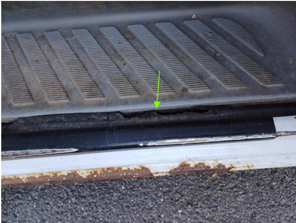
Bild 21 : Tür vorne links, Tüрдichtung gerissen
